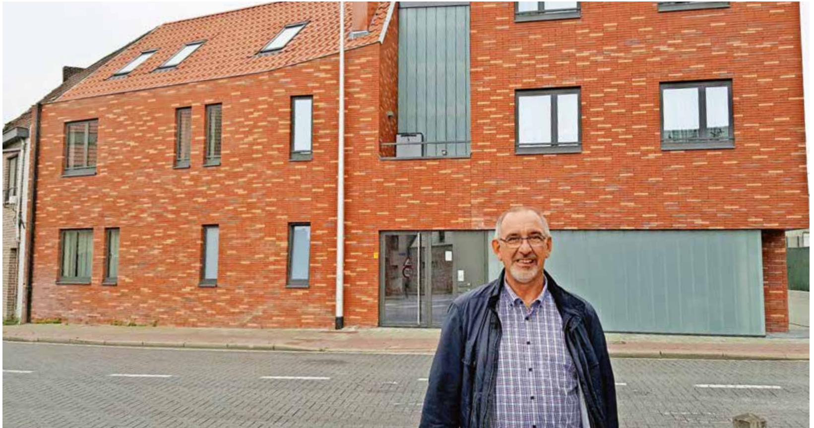
Walter Troch aan de vijf huurappartementen van De Ideale Woning, aan de Matenstraat vlakbij het station. Begin 2013 gingen er drie krotwoningen onder de sloophamer.
